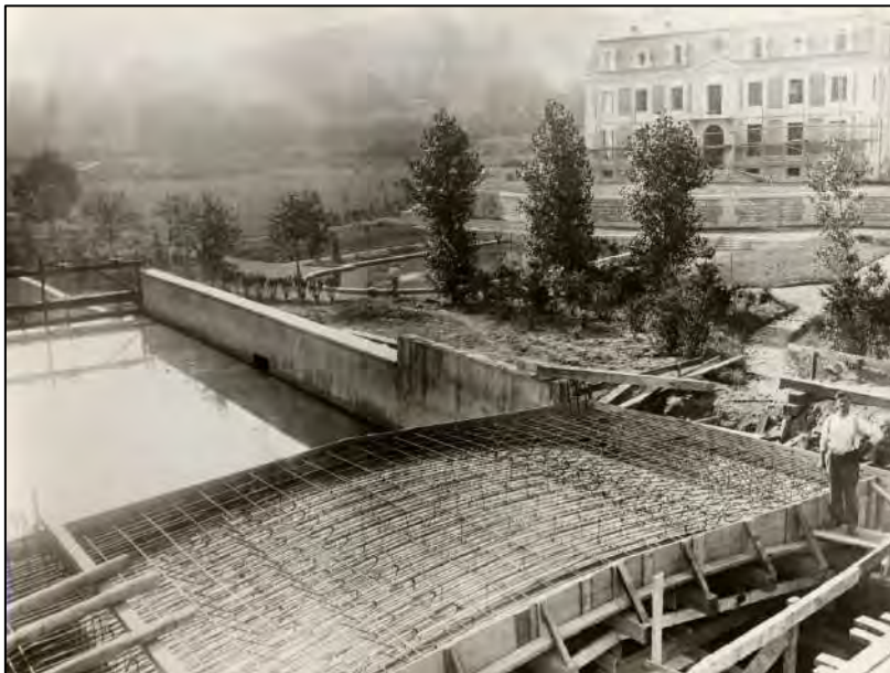
Construction du pont
