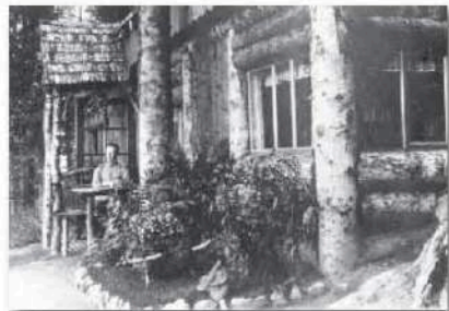
Une maison fortifiée en bois
