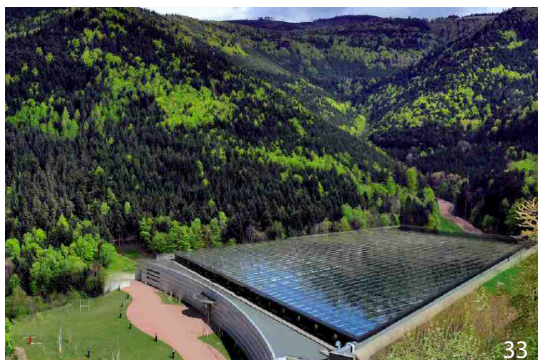
33. VUE AÉRIENNE DU PARC MINIER TELURE
