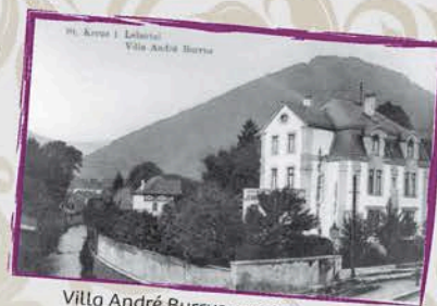
Villa André Burrus rue de la gare. Photo CCVA
